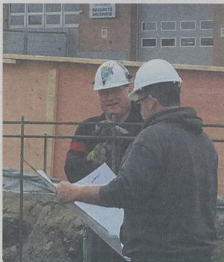
On voit ici le chantier Visa-Beauté de Lac Mégantic. (Photo - Gracieuseté)
