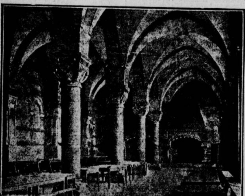
LE REFECTOIRE DANS LA PARTIE MODERNE DES BATIMENTS DE L'ABBAYE.
