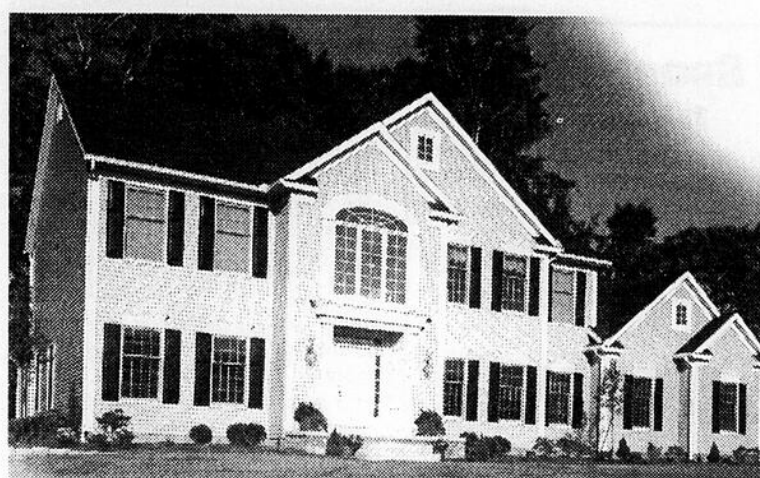
Le revêtement de vinyle apporte une plus-value à votre résidence. (Photo Produits de bâtiment GENTEK)
