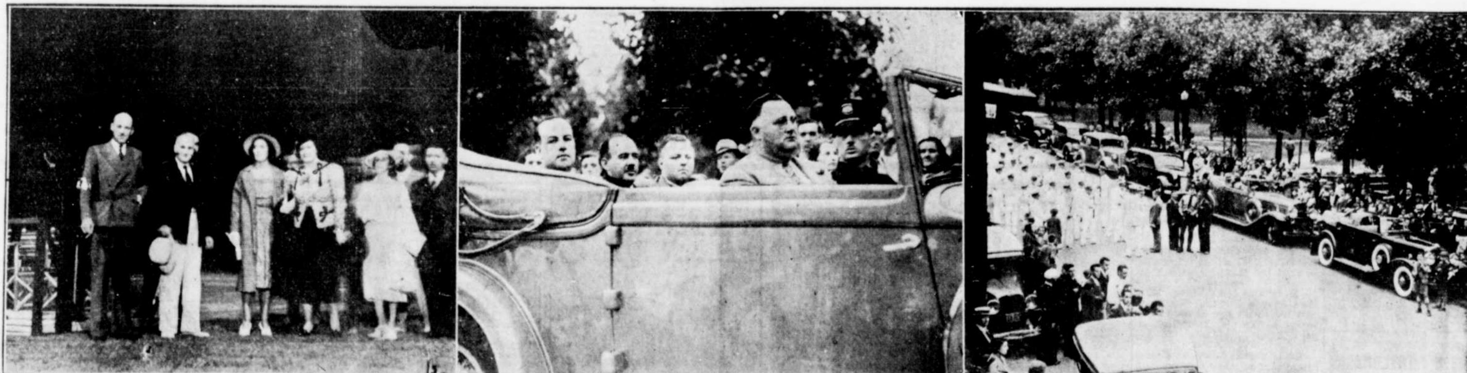
Hier soir, avait lieu l'ouverture officielle du Stade de baseball sur l'hon. Johnny Bourque, ministre des Travaux Publics. Dans la première photographie, prise au terrain de baseball, on reconnaît, de gauche à droite: l'hon. Johnny BOURQUE; Son Honneur; le maire M.-T. ARMITAGE, Mlle Fredericka BRADLEY; Mme Johnny BOURQUE. Dans la deuxième photo, on aperçoit les officiers du club: MM. Lucien DUGRE, Hertel O'BREARY, Rosario GAGNE, et le Dr A.-N. DUPLIS. Enfin, dans la dernière photographie, on voit une partie de la foule au Parc Dufresne, avant la parade.
