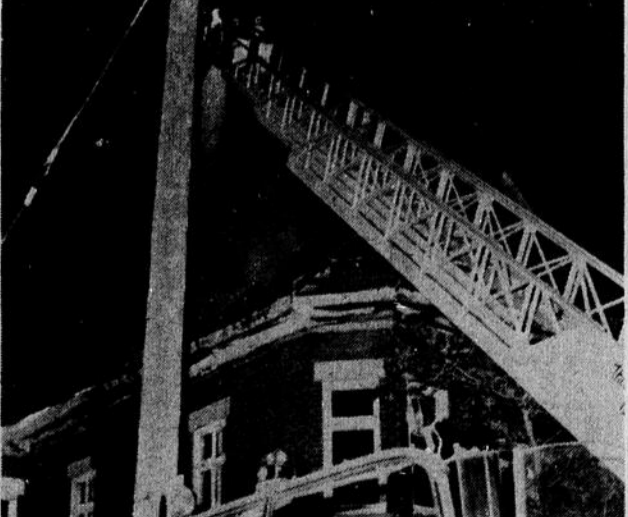
Le toit de l'immeuble s'est effondré dès que le feu eut fait ses ravages (Photo Martial Coderre).
