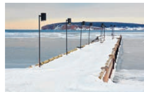
La mairesse de Percé, Cathy Poirier, a exprimé son souhait de voir les travaux s'enclencher dès l'automne 2018.
