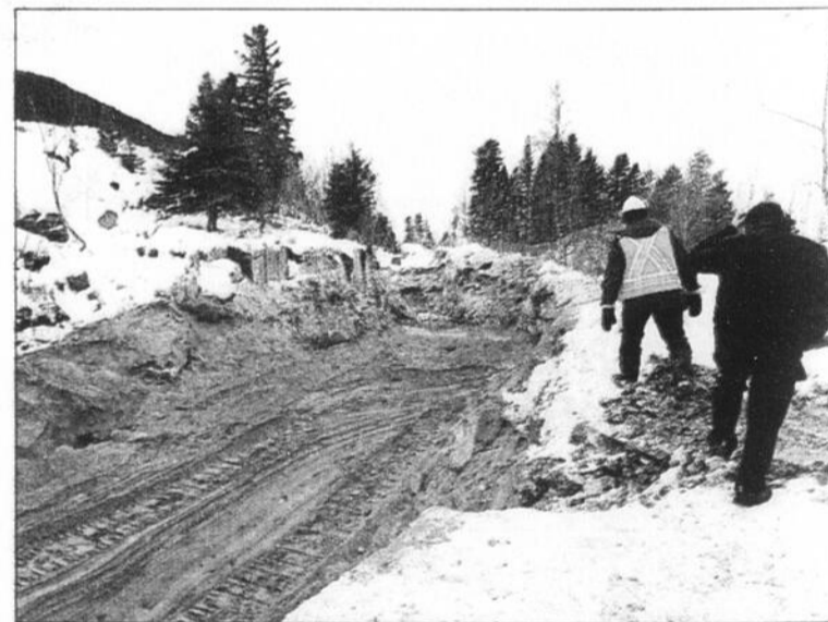
Depuis le mois d'août, les bouteaux et la machinerie lourde sont à l'oeuvre pour procéder à l'excavation de dizaines de mètres de roc en vue de l'ouverture d'une nouvelle rue privée dans le secteur de Rivière-du-Moulin.
