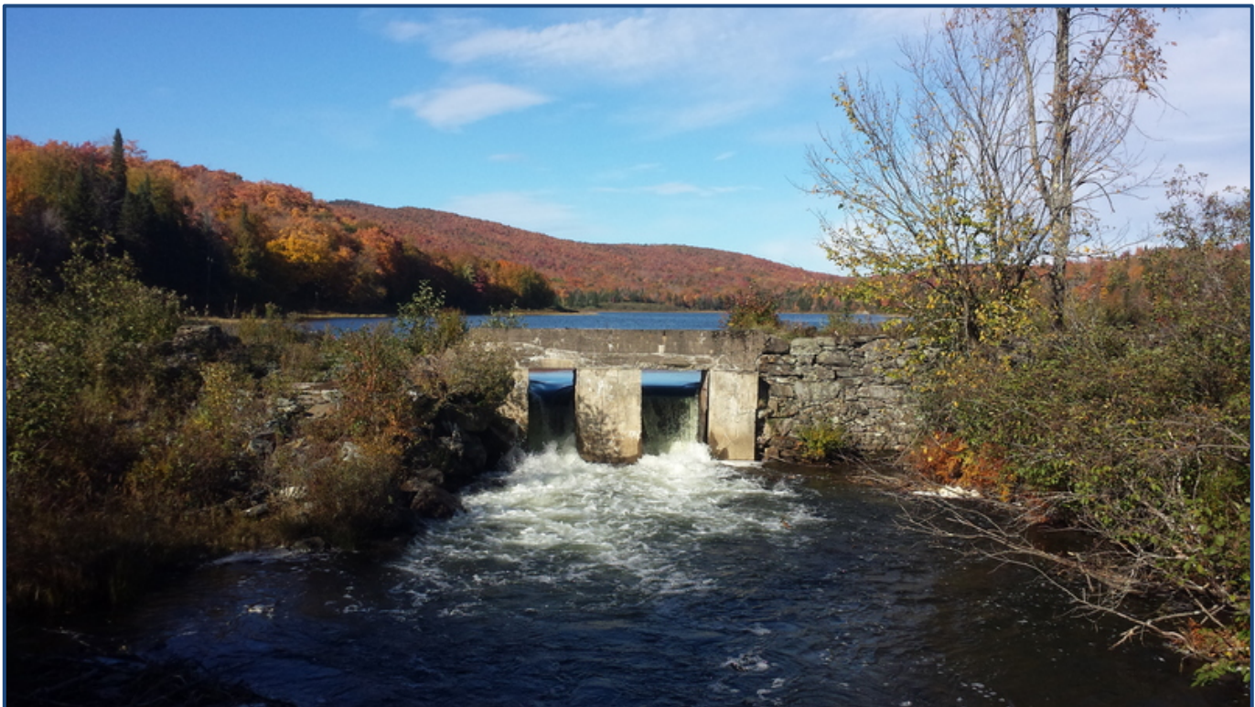
L'étang Fullerton et son barrage David Brisson | 2016
