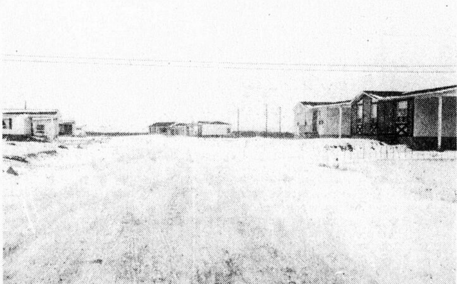
SIX NOUVEAUX QUARTIERS — Pour satisfaire à la demande des personnes désireuses de s'établir à Saint-Félicien, la ville a dû mettre en chantier six nouveaux quartiers. Sur ces vignettes, on remarque le quartier Laflamme, et Bouchard.
