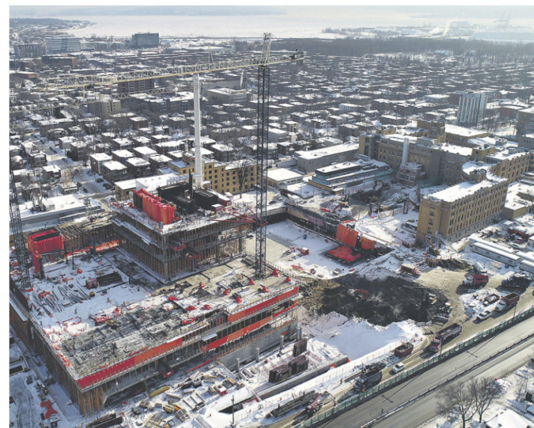
CHANTIER DE L'HÔPITAL DE L'ENFANT-JÉSUS – PHOTO: LE SOLEIL
