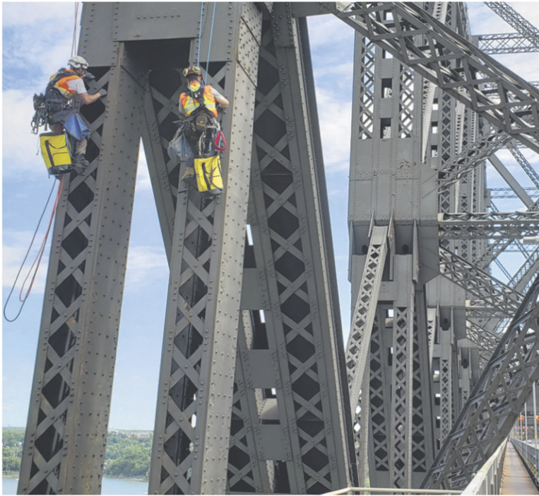
INSPECTION DU PONT DE QUÉBEC
