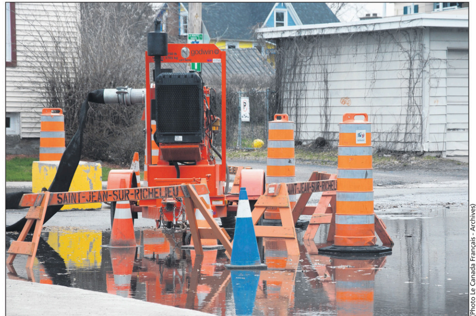
Pour éviter les refoulements d'égouts sanitaires, la Ville doit installer des pompes mobiles sur la rue Bellerive.
