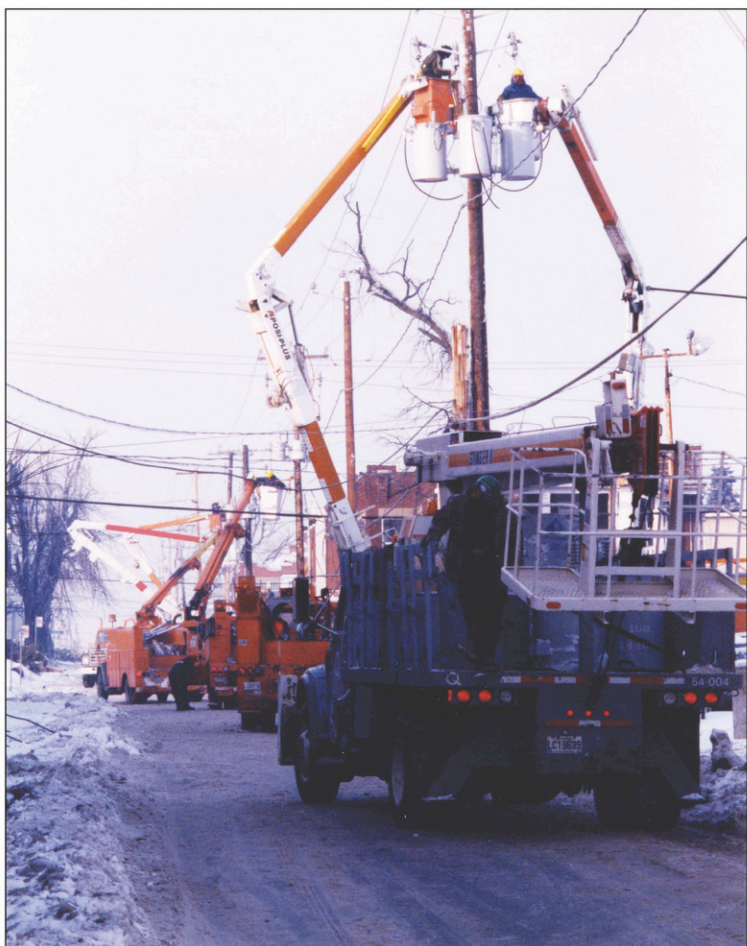
Ballet des nacelles sur la rue Saint-Georges, à Saint-Jean, alors que la grande opération de rétablissement du réseau est enclenchée.
