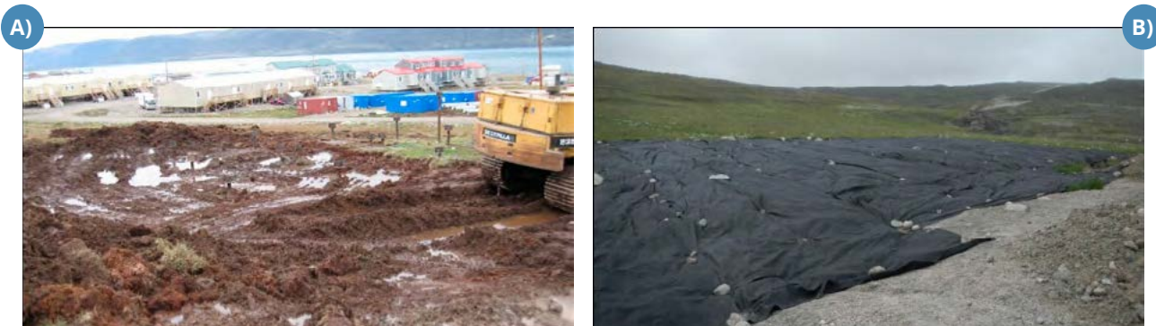
FIGURE 5.85 : A) PERTURBATION DU TERRAIN LORS DE LA MISE EN PLACE D'UNE FONDATION SUR PIEUX À PANGNIRTUNG AU NUNAVUT (SOURCE : E. L'HÉRAULT, CEN, 2010). B) MISE EN PLACE D'UN GÉOTEXTILE SUR LE SOL NATUREL AFIN D'ÉVITER LA MIGRATION ET LE MÉLANGE DES MATÉRIEAUX IN SITU AVEC CEUX QUI COMPOSENT LE REMBLAI GRANULAIRE À SALLUIT AU NUNAVIK.
