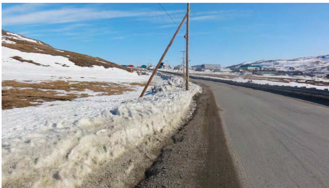
FIGURE 5.48 : IMPORTANTE ACCUMULATION DE NEIGE CONTRE LE REMBLAI DE LA ROUTE DE L'AÉROPORT À SALLUIT EN MAI 2011. LA ROUTE A DÛ ÊTRE RECONSTRUITE EN 2012 POUR RÉPARER LES DOMMAGES CAUSÉS PAR LA DÉGRADATION DU PERGÉLISOL.
