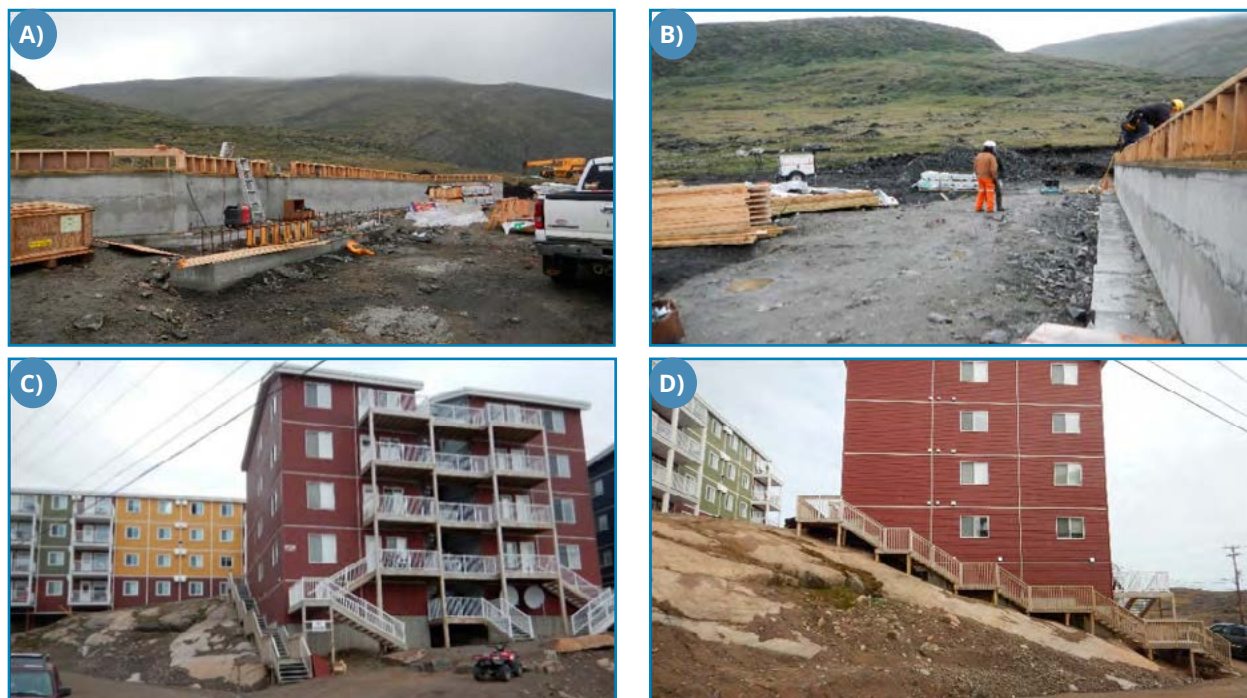
FIGURE 5.70 : A) ET B) MUR DE FONDATION SUR SEMELLE FILANTE REPOSANT SUR UN SUBSTRAT ROCHEUX NIVELÉ À KANGIQSUJUAQ AU NUNAVIK, C) ET D) MUR DE FONDATION SUR SEMELLE FILANTE QUI REPOSE SUR UN SUBSTRAT ROCHEUX INCLINÉ À IQALUIT AU NUNAVUT.
