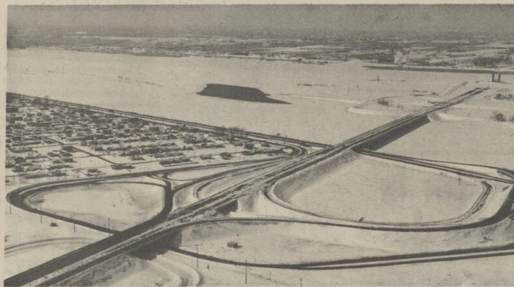
L'échangeur situé à l'entrée sud du pont-tunnel Louis-Hippolyte Lafontaine assure la communication entre la Transcanadienne, vers Québec, et les routes no 3 et Marie-Victorin, en bordure du fleuve.
