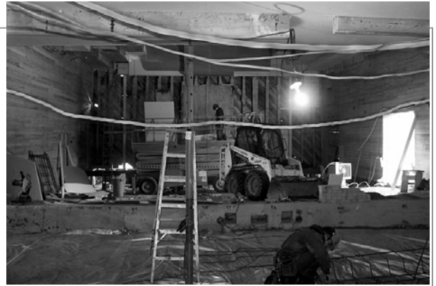
Salle de Ville-Marie en construction Photo : Corporation de la salle Augustin-Chénier
