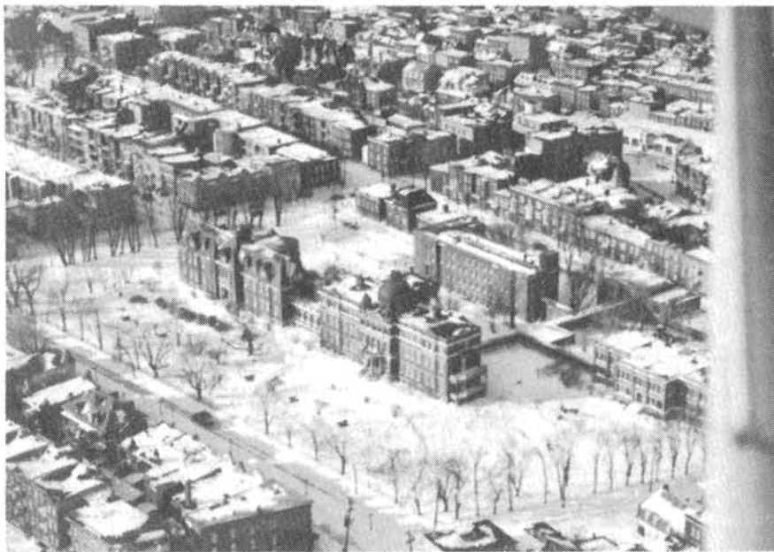
Vue aérienne du Jeffery Hale's Hospital (Rue St-Cyrille).
