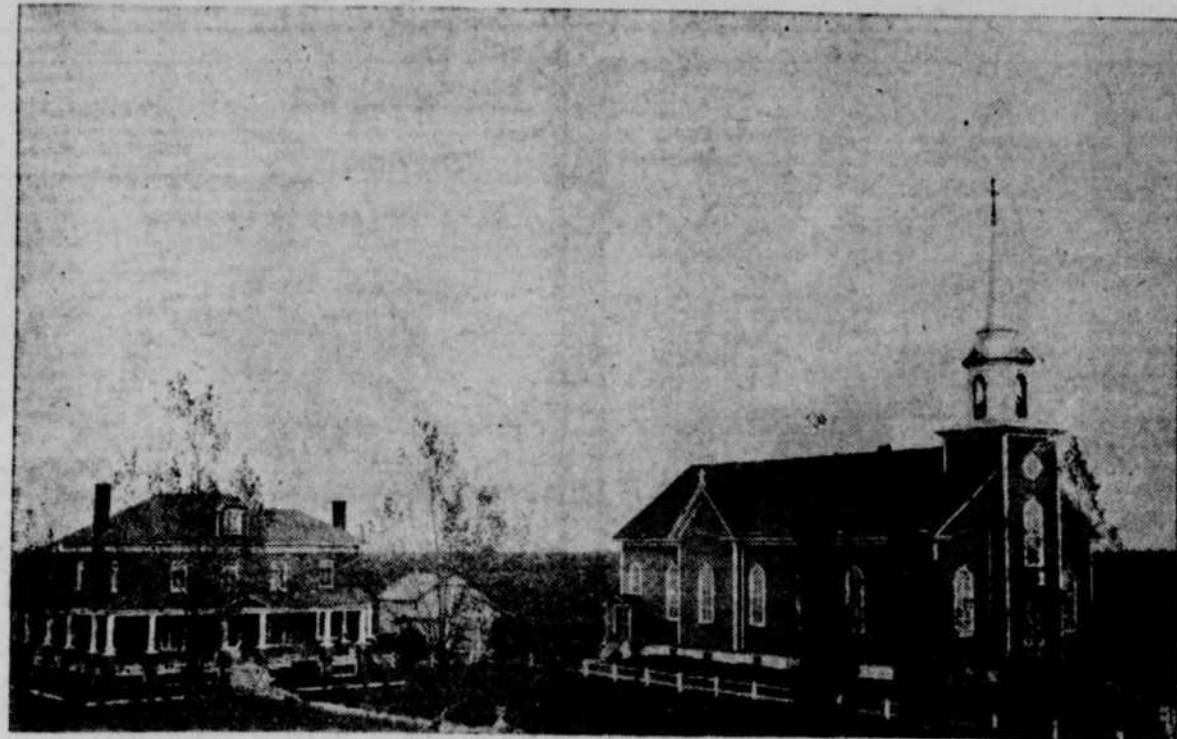
● EGLISE et PRESBYTERE de VILLEROY
