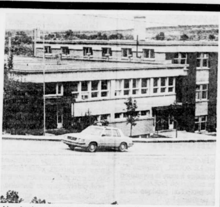
L'ancien immeuble de l'usine St. George Shoe sera complètement transformé en centre municipal des congrès, avec hôtel, restaurant et bar.
