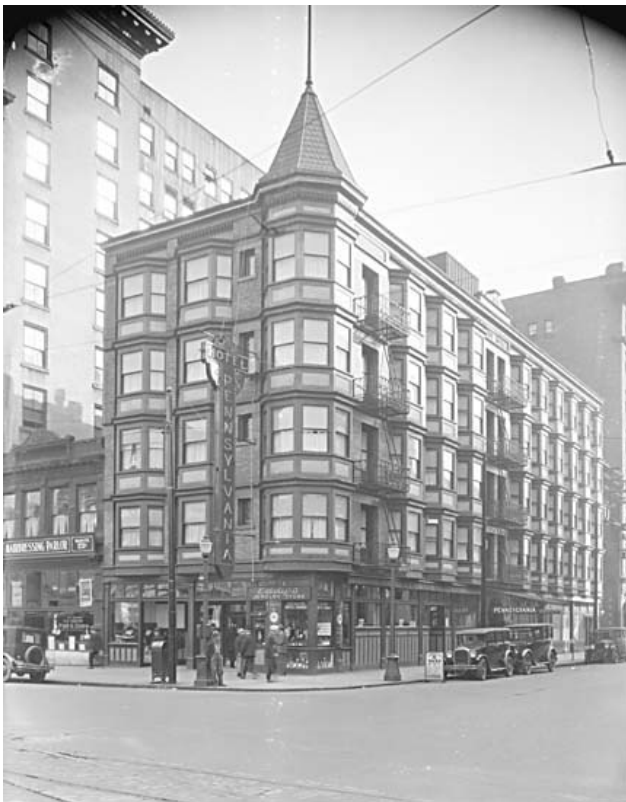
L'hôtel Pennsylvania, dont la rénovation a été terminée en 2008, est l'édifice où la PHS a commencé ses activités. Il est le premier édifice offrant des unités complètes, les autres étant des maisons de chambre avec services partagés.
