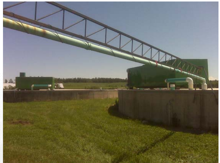
Les Élevages Parent : deux fosses de 30,48 m de diamètre par 3,65 m de hauteur avec toiture de béton surmontée par un biofiltre.
