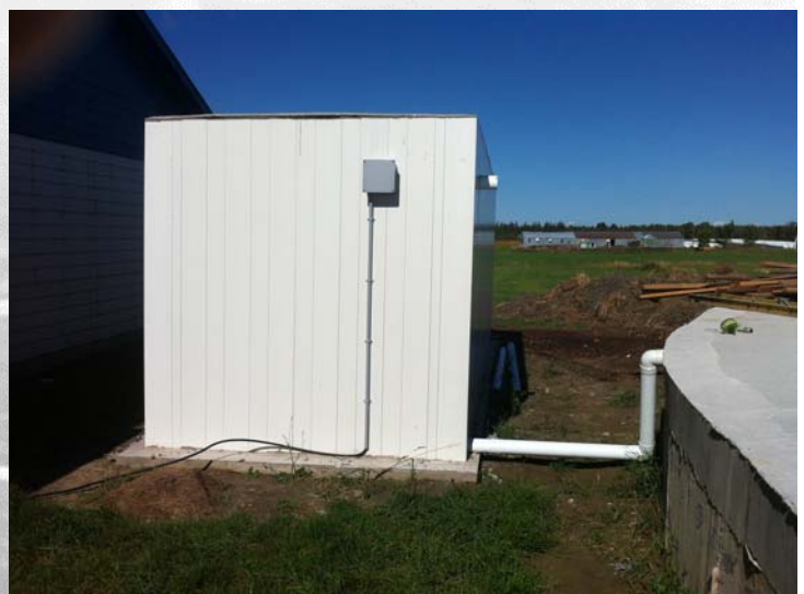
Ferme R et R Fortin : autre exemple d'un biofiltre, cette fois contigu à une fosse de 35,96 m de diamètre par 3,65 m de hauteur avec toiture en béton.
