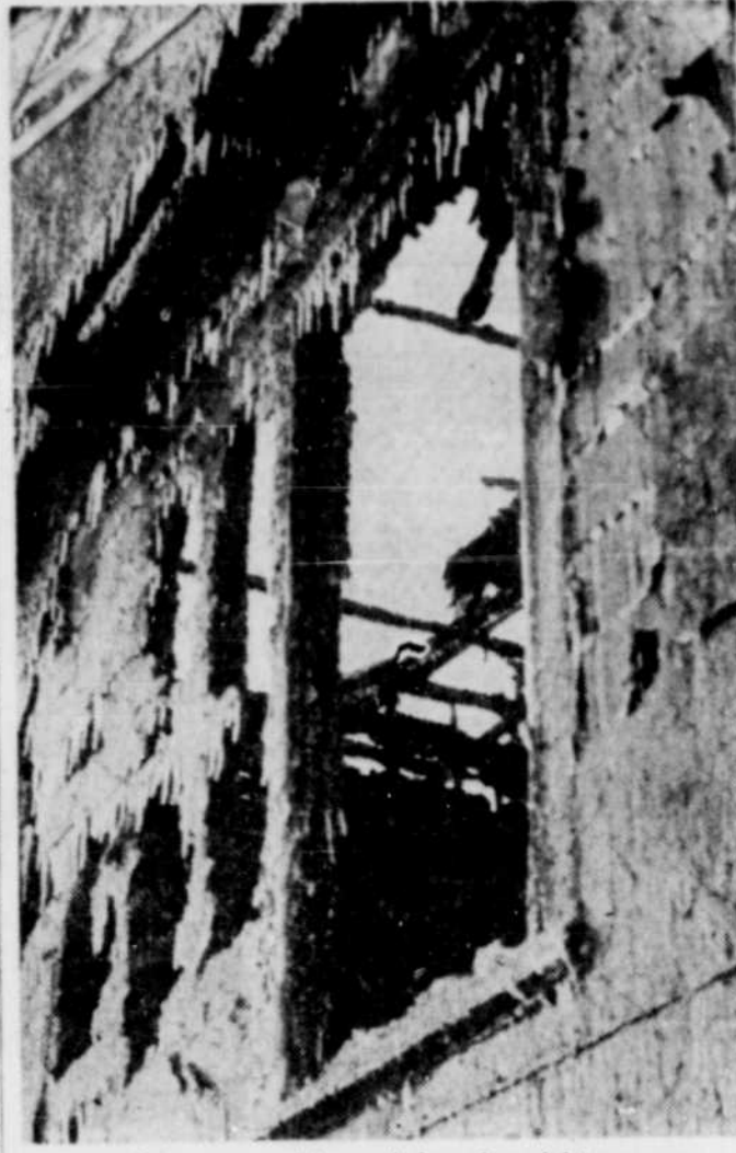
Deux vues extérieures de la maison sinistrée. (Photo La Tribune)
