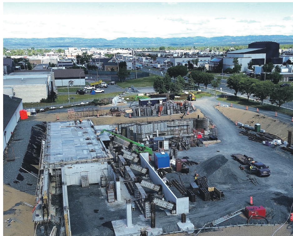
Le nouvel aréna aura une patinoire de dimensions conformes aux standards de la LNH et une capacité d'accueil de 1 800 places (dont 1 500 assises). Photo courtoisie
