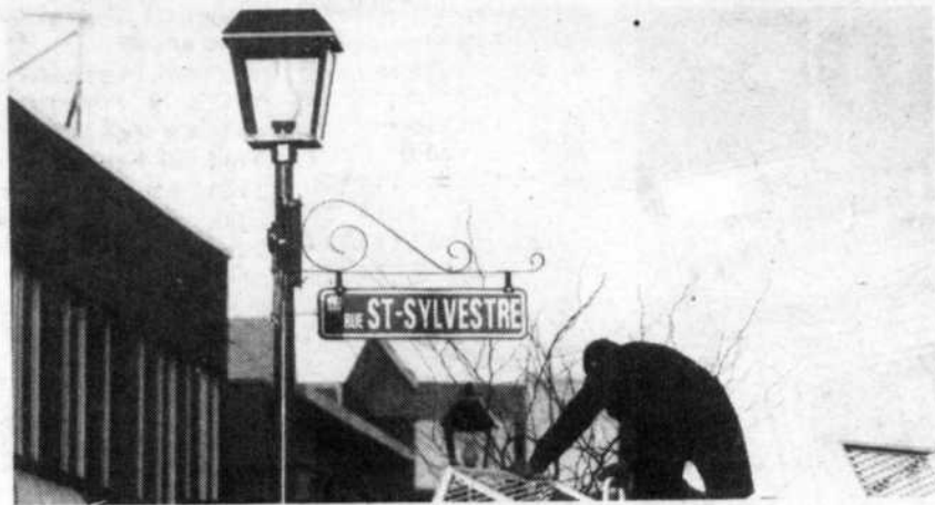
(F.L.) Jeudi dernier, les employés de la ville de Longueuil procédaient à l'installation des panneaux de rue qui orneront les intersections de la rue St-Charles dans le vieux Longueuil. Il s'agit d'une des dernières étapes de l'aménagement de cette artère commerciale dont on a refait une beauté depuis quelques mois. Les nouvelles plaques s'harmonisent avec les lampadaires qui ont été installés il y a quelques jours. (Photo Danny McKenzie).
