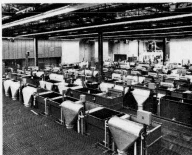
Figure I — Vue du procédé de placage des nouveaux ateliers d'entretien des moteurs de Air Canada à Dorval, Québec. On peut voir notamment les bassins, les tuyaux pour le système de ventilation à alimentation et évacuation contrôlées, ainsi que les planchers en treillis métallique et les régulateurs de conductivité sur les bassins de rinçage.
