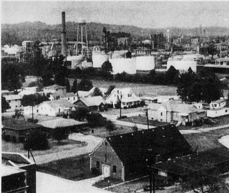
INDUSTRIE — C'est dans cette usine d'Institute, en Virginie Occidentale, que les inspecteurs ont relevé 221 infractions aux lois fédérales en matière de protection de l'environnement et de la santé.
