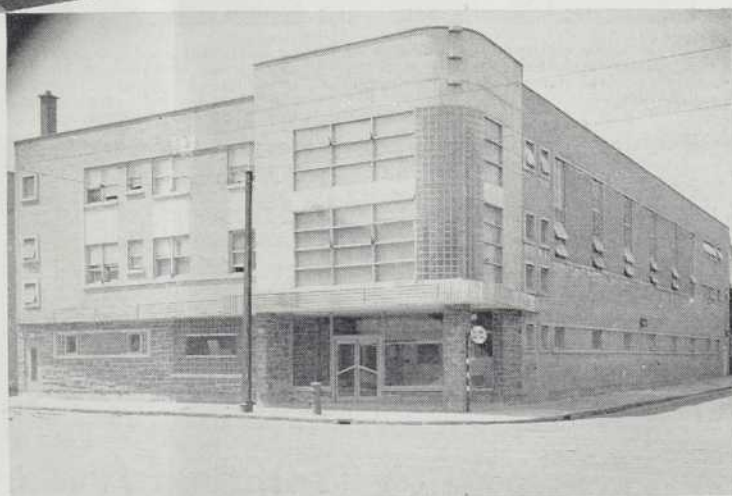
Architecte : J. Eugène Perron
