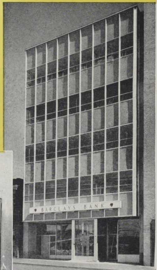
La Banque Barclay's, Toronto Architecte: Blake H. M. Tedman, Toronto
