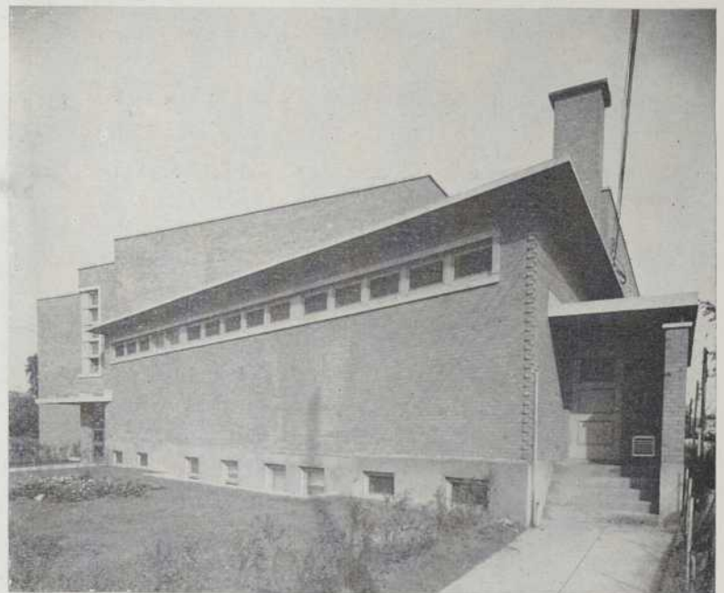
Ci-haut, façade de la rue Plamondon. Répartition de masses et lignes capricieuses qui étonnent un peu.
