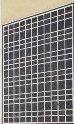
Meneau noirci à l'électrolyse
