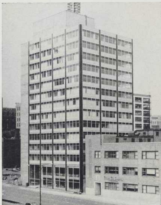
Edifice 505 Dorchester West Architecte : Reuben Fisher
