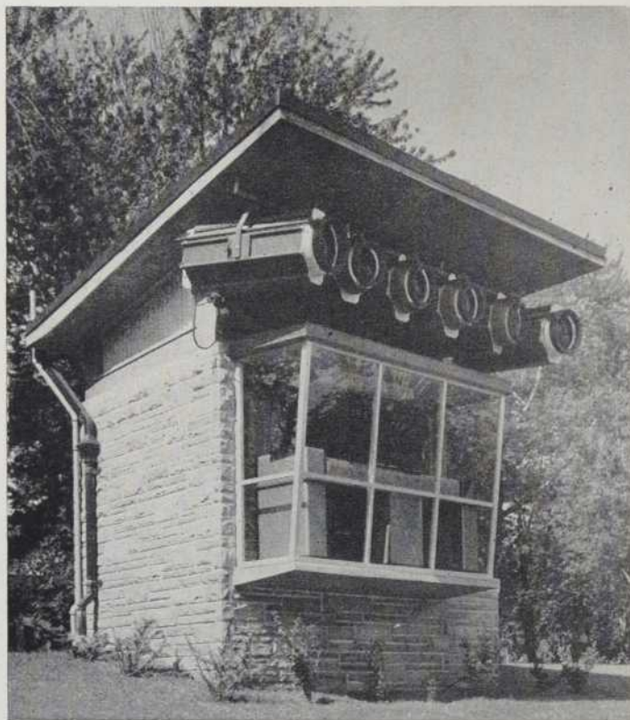
Fig. 2 — La cabine de contrôle avec la batterie de projecteurs.
