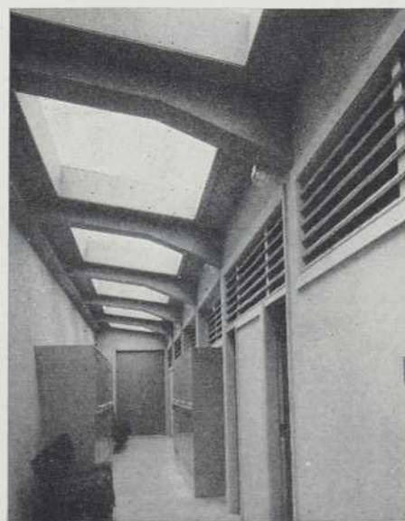
Fig. 10 — Détail du corridor conduisant aux salles de maquillage à l'arrière-scène.
