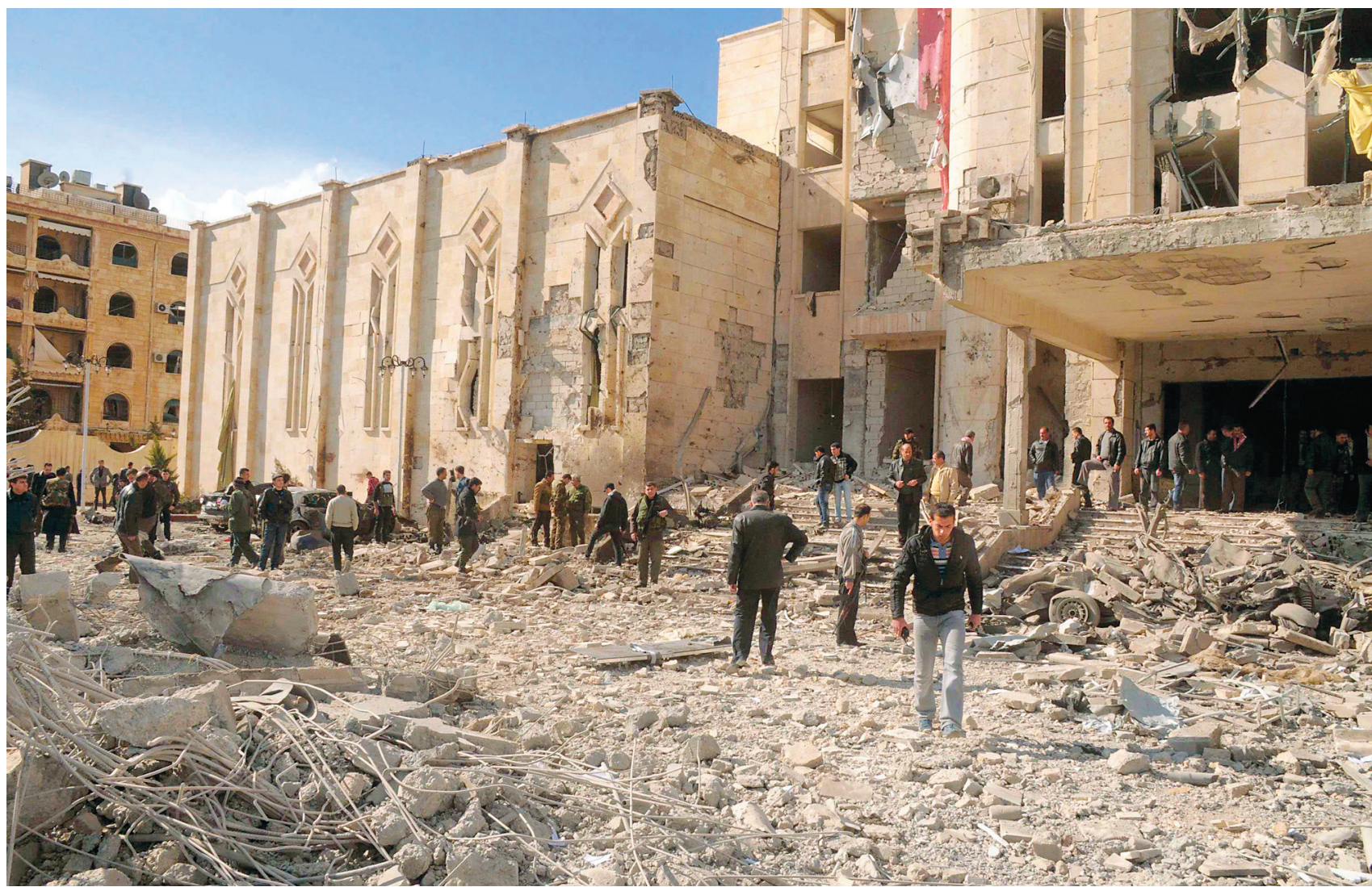
Les explosions ont endommagé des bâtiments des forces de sécurité à Alep, la deuxième ville du pays.
