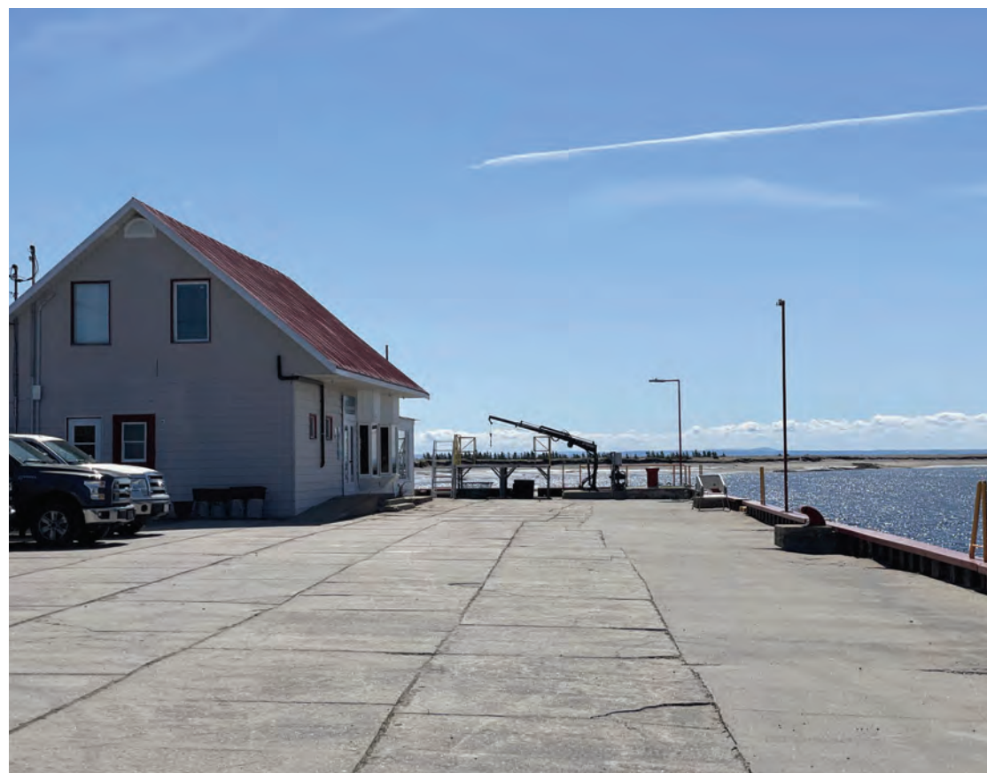
Le bâtiment municipal situé au quai de Portneuf-sur-Mer bénéficiera d'une mise à niveau de son système de traitement des eaux usées, dont les coûts sont estimés à 267 448 $.
