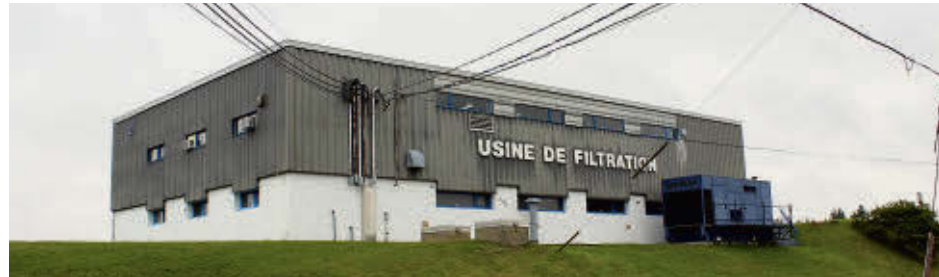
Située en bordure de la route 249, l'usine de filtration des eaux restera au même endroit avec un accroissement de 33 pour cent de sa superficie.
