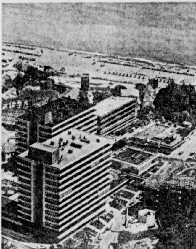
Le décor de Torremolinos s'est transformé pour faire place à la masse imposante des hôtels de luxe, en bordure de la plage.
