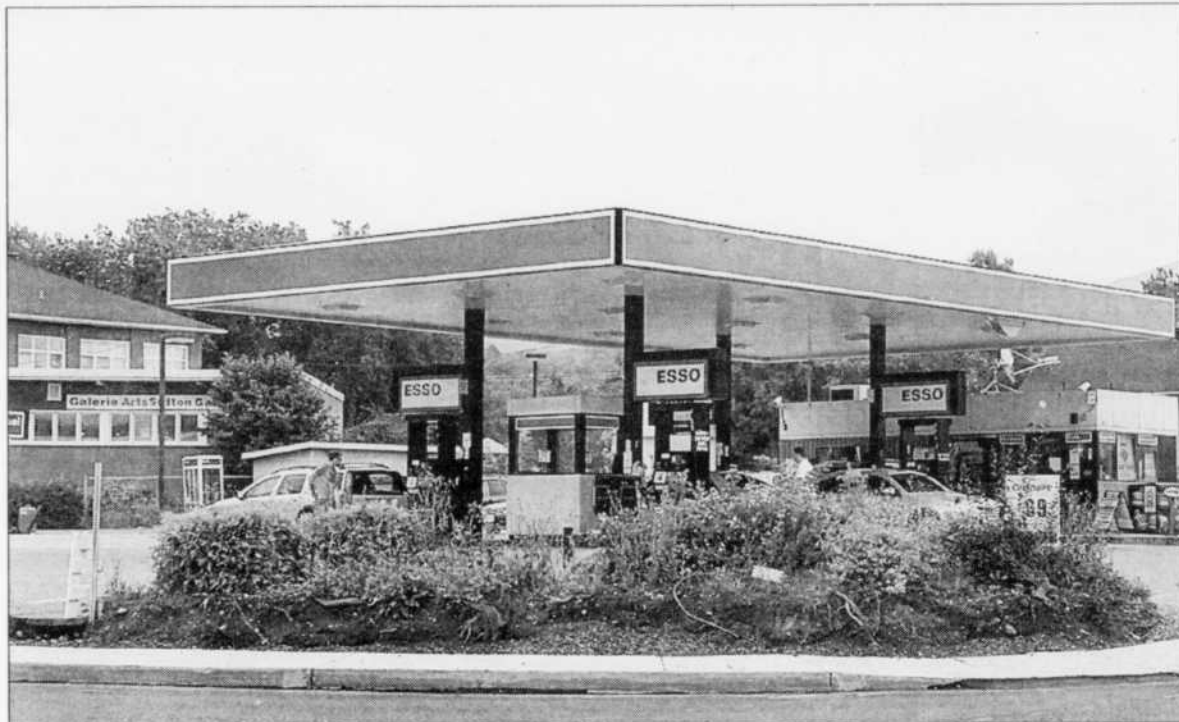
Alimentation Couche-Tard veut démolir la station-service Esso, située au coin des rues Principale et Academy, pour y bâtir un dépanneur de 3000 pieds carrés avec poste d'essence.
