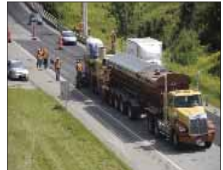
Mini usine automotrice pour la fabrication de l'enrobé à froid
