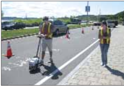
Figure 1 : Profilomètre « SURPRO » utilisé pour caractériser les profils longitudinaux et transversaux des sections du programme de suivi des chaussées municipales (Photo par Jérôme Fachon)
