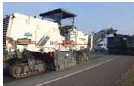
Figure 3 : Machinerie à l'œuvre
