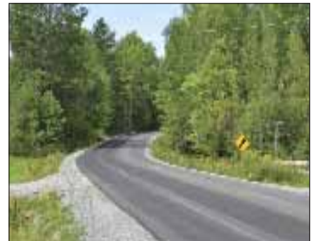
Route une fois terminée
