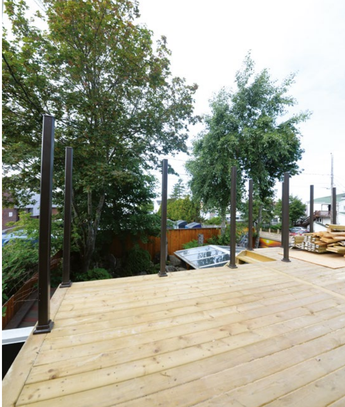
■ Le 2 e étage de l'immeuble comportera maintenant une terrasse
