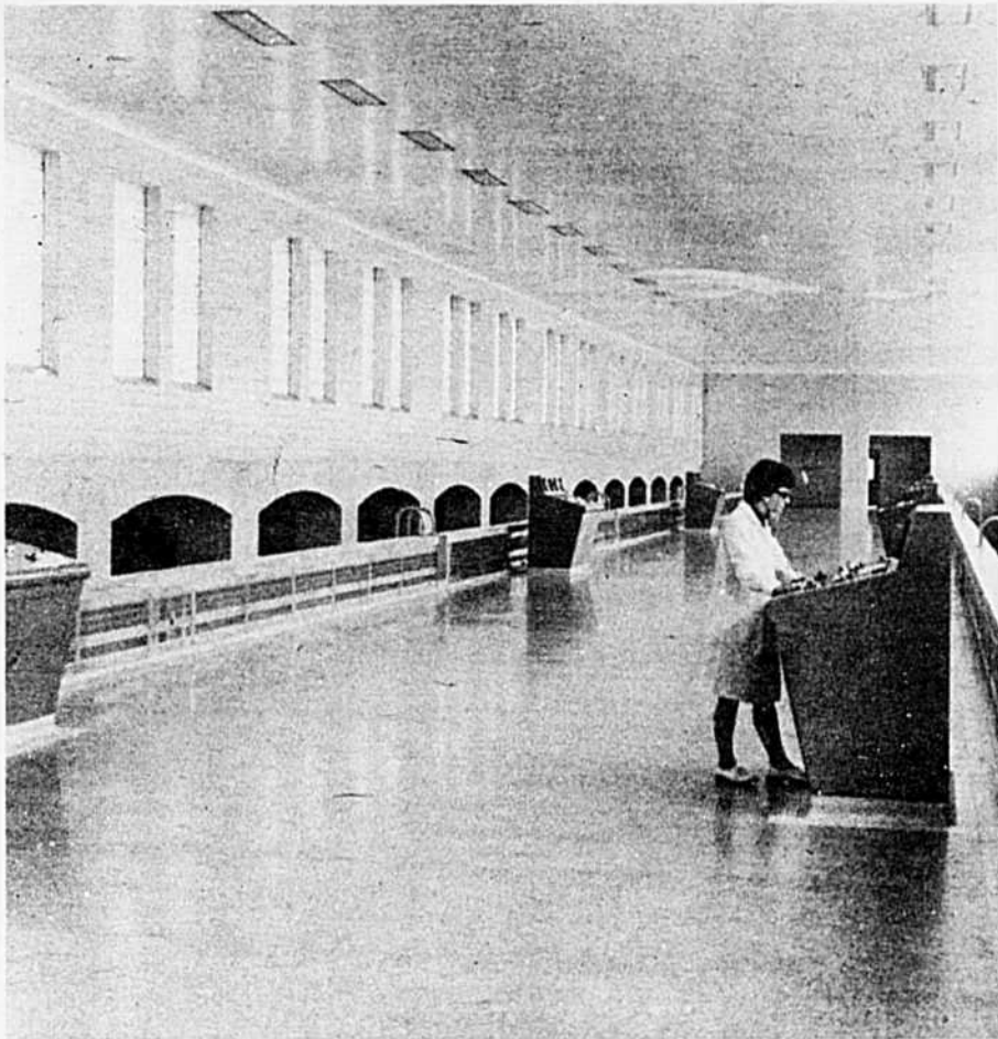
L'aqueduc de Montréal renferme sept couloirs de filtration identiques à celui-ci.
