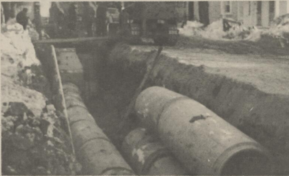
AQUEDUC ET EGOUTS - Des travaux se poursuivent depuis quelques semaines à St-Dominique, en vue de l'amélioration du service d'aqueduc et d'égouts.
