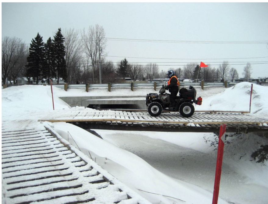
Pont aménagé dans Saint-Basile-le-Grand près de la route 116
