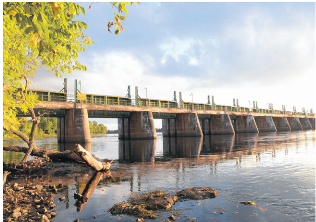
Le barrage Fryer, à l'abandon depuis des décennies, sera transformé grâce à un investissement de 7,4 M$ du gouvernement fédéral. Des études sont toujours en cours avant l'élaboration du projet final. (Photo: TC Media – Jean Laramée)
