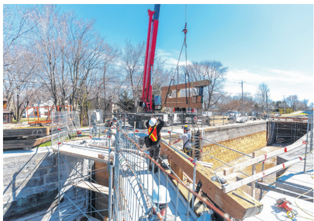
Parcs Canada donnait accès aux médias à son chantier à l'écluse #5, le 21 avril, dans le cadre de l'étape finale des travaux de remplacement des quatre portes de bois de l'écluse. (Photo: TC Media – Denis Germain)
