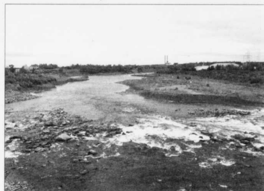
ÉLECTRICITÉ - Selon Hydro-Québec, il n'y a pas de contentieux entre le gouvernement fédéral et Hydro-Québec concernant le coût de reconstruction des ouvrages de retenue de Pont-Arnaud et Chute-Garneau.
