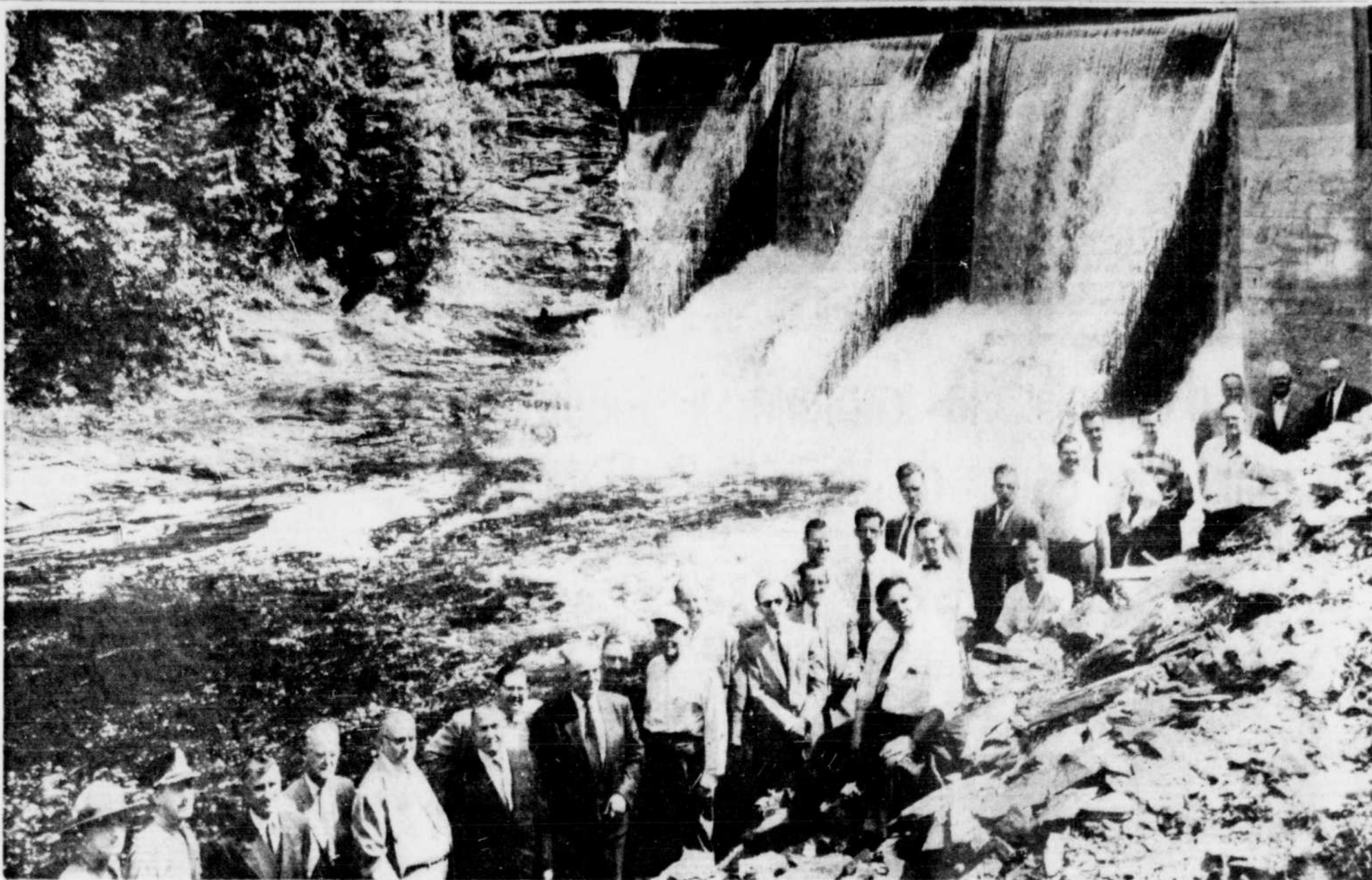
VISITE AU FILTRE DE RICHMOND — Plusieurs personnalités ont visité hier le système d'aqueduc de Richmond. On les voit ici au filtre municipal du chemin de Kingsbury. On remarque entre autres S. H.
