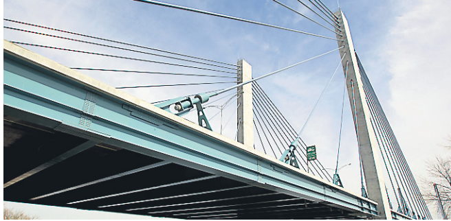
Pont de l'autoroute 25
