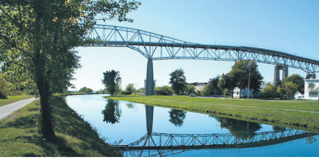
Pont international de la Voie maritime
