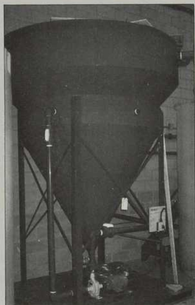
Un réacteur typique pour l'enlèvement des métaux dissous dans les eaux industrielles.
