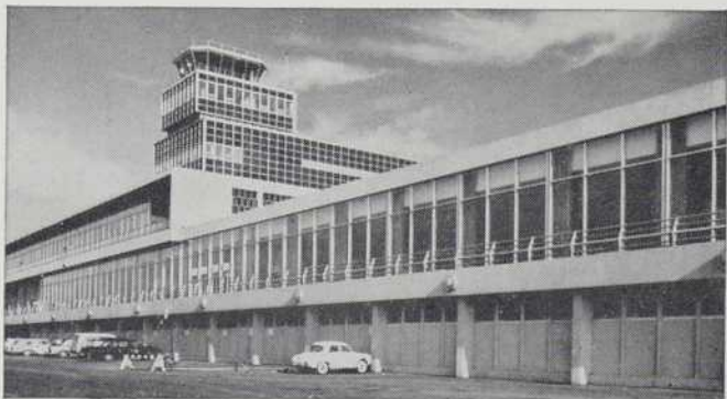
Installation de Twindow à l'aérogare internationale de Montréal, à Dorval.
