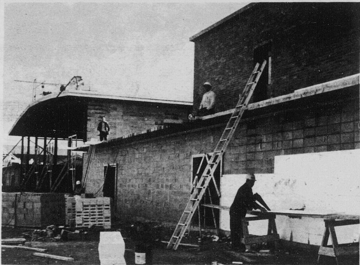
Photo aérienne des "Galeries Lac-St-Jean", prise au cours des travaux, il y a quelques mois. L'on sait que ce centre-d'achat est ouvert depuis hier matin.
