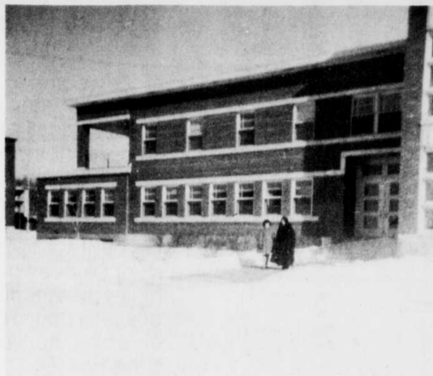
La résidence Coeur-Immaculé, lors de sa construction en 1960, ne se trouvait pas encore reliée à l'école Chalifoux, dont on aperçoit un coin à gauche de la photo.
