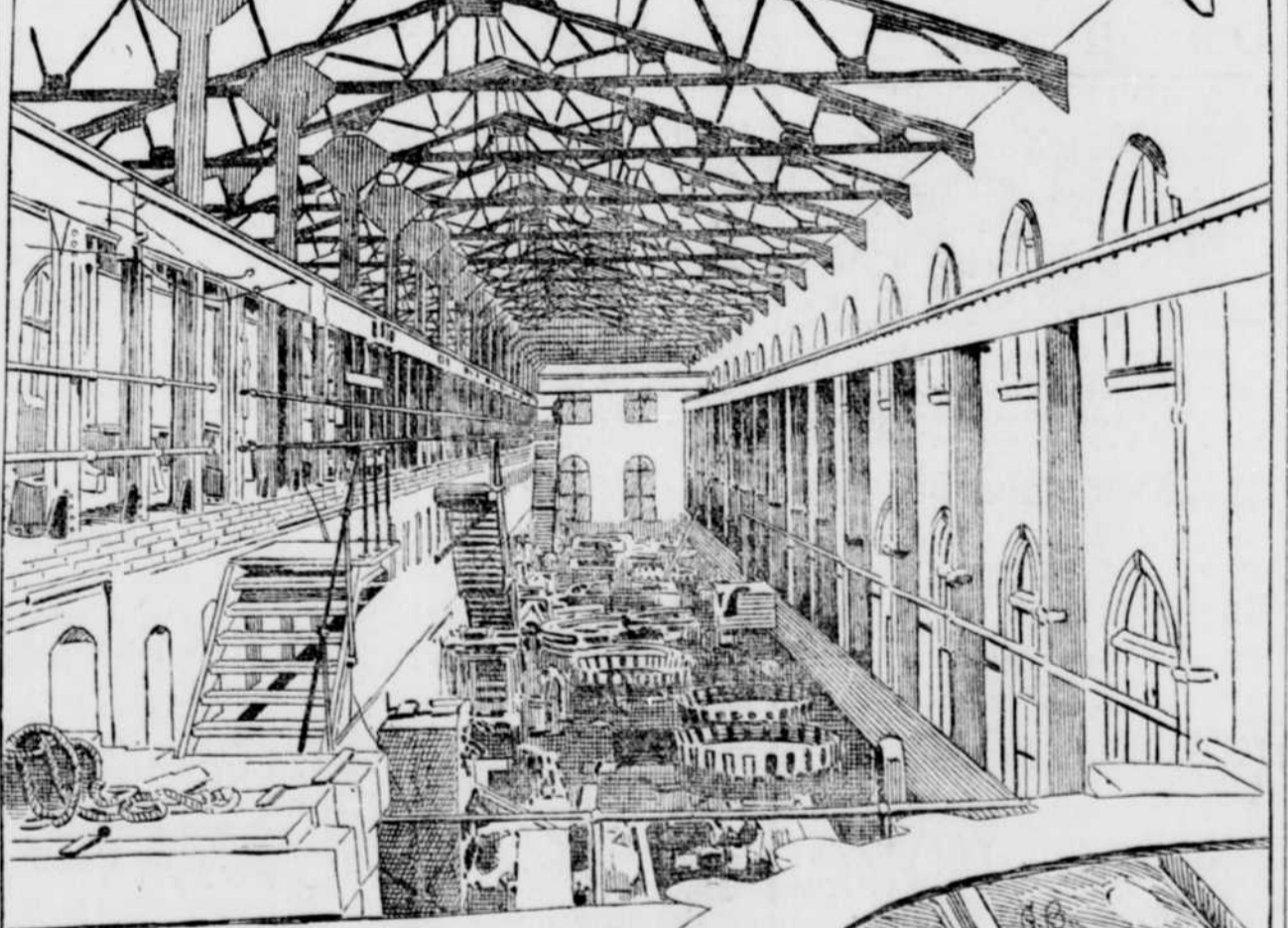
Vue de l'intérieur des usines électriques à Chamblly.
