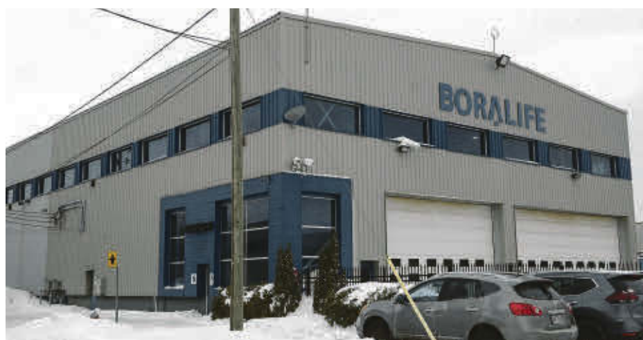
L'usine Technologies Boralife, en activité depuis le début de 2022, est implantée au 600, rue Cormier à Sorel-Tracy. Photo Les 2 Rives ©
