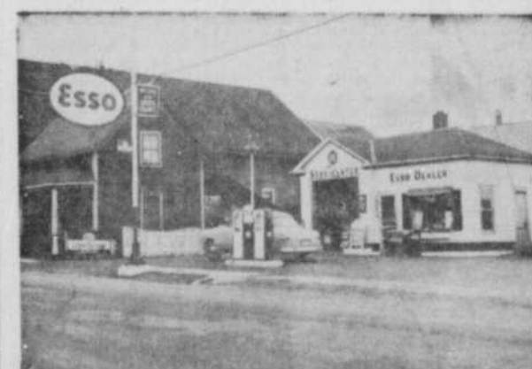
Un poste de service important dans le centre d'Island Pond, Vt., en face du théâtre Roxy.
