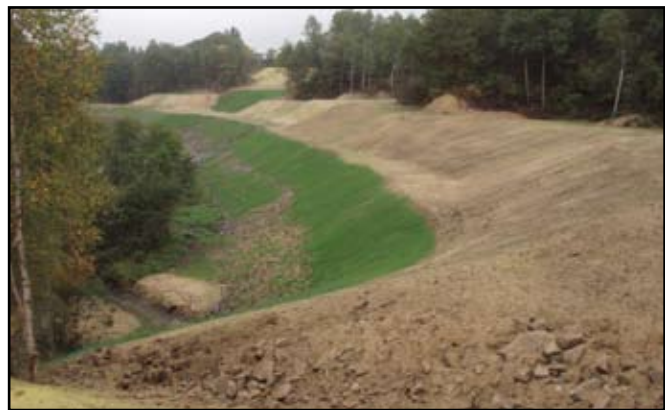
Talus stabilisé le long du ruisseau Bellevue-Lavergne à Shawinigan
