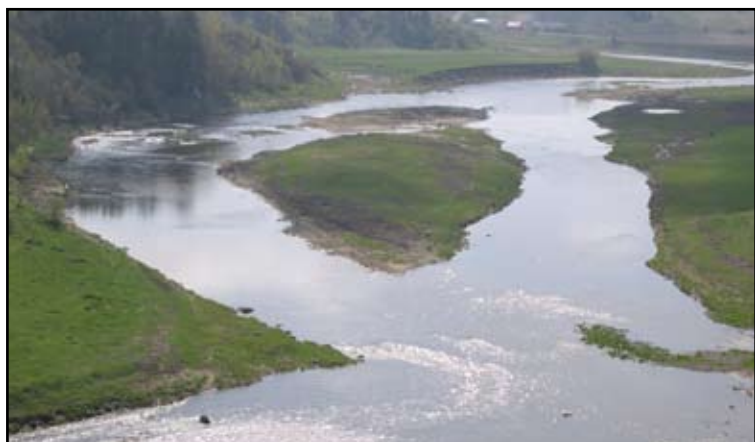
Vue aérienne du secteur à stabiliser le long de la rivière Nicolet à Sainte-Monique
