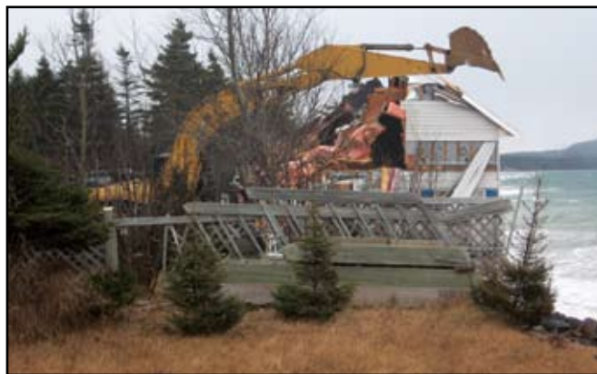
Démolition d'une maison à Sept-Îles
