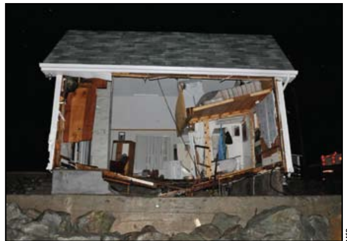
Cette maison a été lourdement endommagée par les grandes marées.
