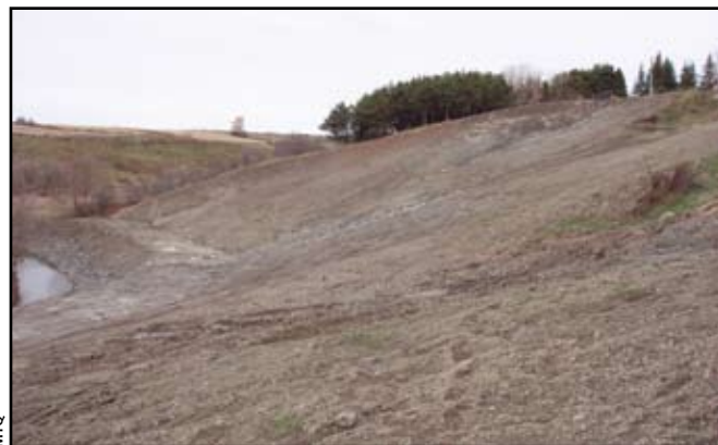
Talus stabilisé à Bécancour
