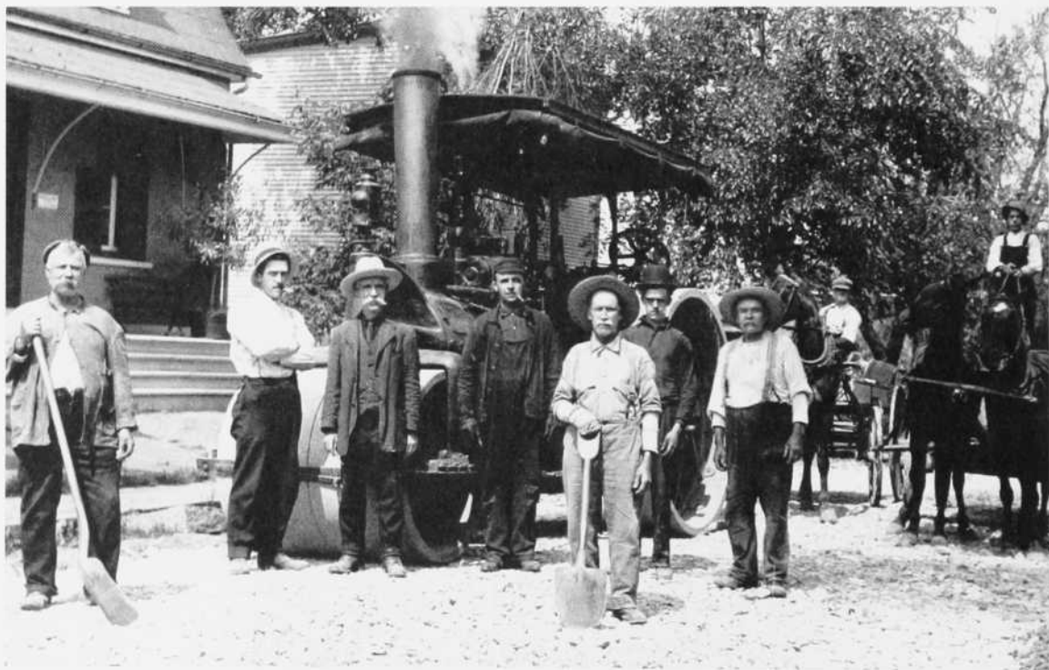
Pose du macadam dans les rues de Chambly en 1910. Le rouleau à vapeur servait à tasser la pierre. (Société d'histoire de la Seigneurie de Chambly)
