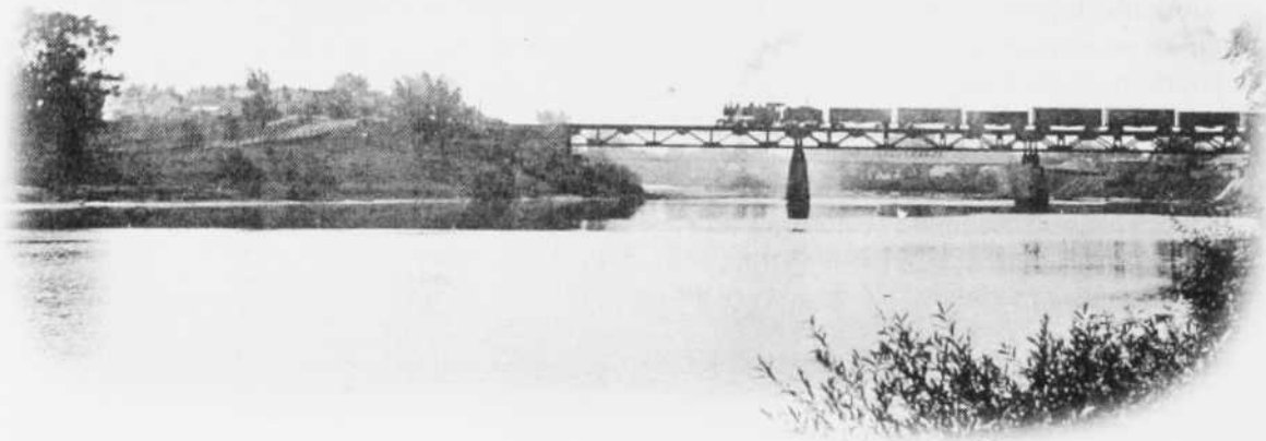
Le pont du Great Trunk Railway sur la Yamaska. La construction du chemin de fer marque un tournant dans le développement urbain. Les municipalités servant de nœuds ferroviaires, comme Saint-Hyacinthe, sont favorisées. (Archives du Séminaire de Saint-Hyacinthe)
