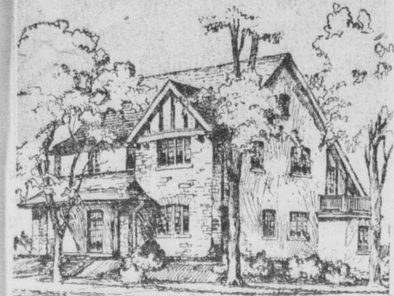
Une maison moderne convenant fort bien à nos conditions atmosphériques.
