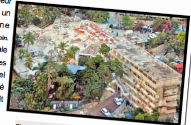
C'est sous ces débris de l' Hôtel Montana , sur les hauteurs de Port-au-Prince , que les corps de Paquerette et Claude ont été retrouvés un mois après le séisme.
